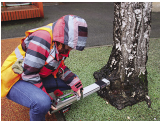
En janvier, l'entreprise Arbonautes a expertisé les arbres de 4 écoles. Ici, sondage réalisé au niveau du collet à l'aide d'un résistographe pour mesurer la profondeur de bois sain.
