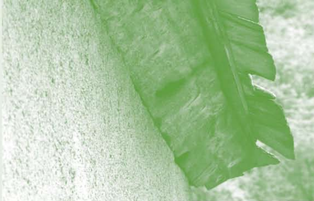
Avec son toit couvert en lauzes de schiste, cette maison est unique à Figeac. Ici, l'égout n'est pas soutenu d'une gènoise mais d'une planche inclinée dans le sens opposé à la pente du toit.
