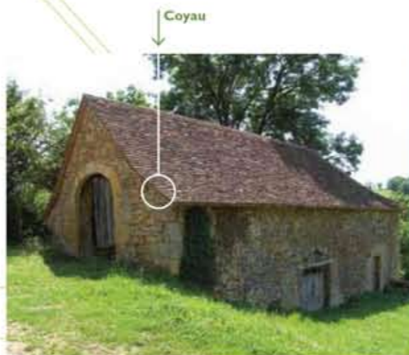
Ci dessus Grange typiquement caussearde portant une toiture à deux pans et pignons couverts, et à tuiles plates.
