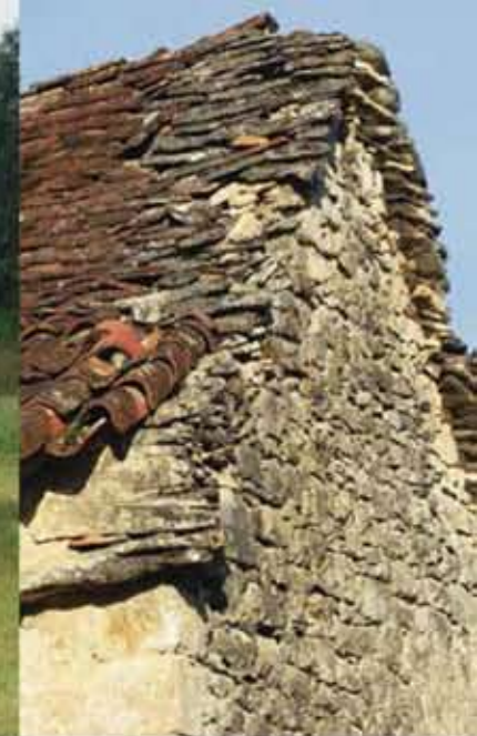
Les pignons de ce logis sont couverts en lauzes de calcaire, traces possibles d'une couverture ancienne.
