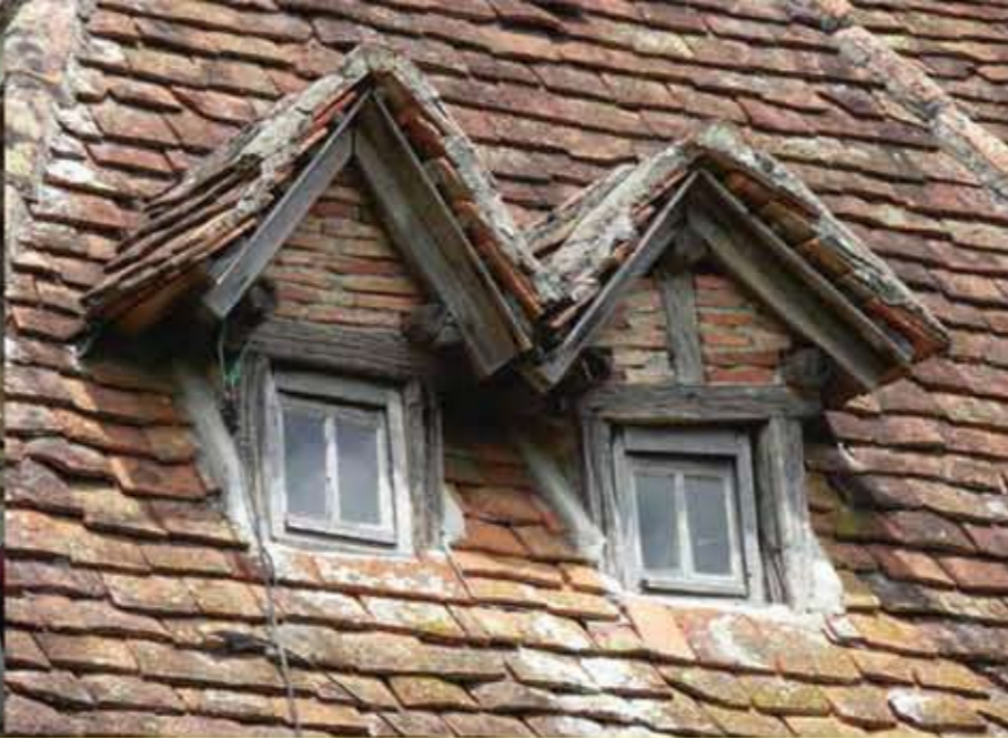
Lucarnes en bâtière.
