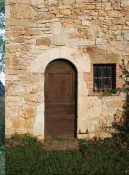
Le logis s'ouvre par une porte dite quercynoise, à lames larges et irrégulières, ménageant un cadre dans la partie supérieure.
