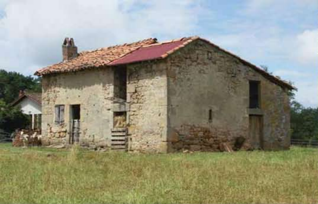
Cette ferme de la deuxième moitié du XIX e siècle de type maison-bloc rassemble sous un même toit un logis et une grange-bergerie-fenil mitoyenne. La grange occupe le comble à surcroît.
