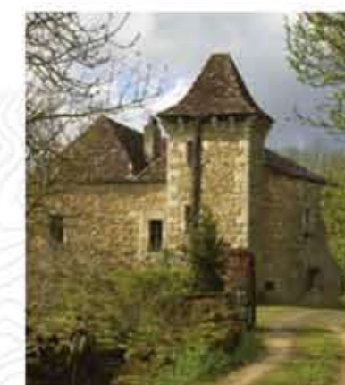
Ci-dessus Cette maison de maître du début du XIX e siècle commande une vaste ferme.
