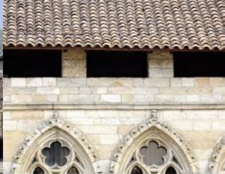
Solelho crénelé en pierre, restitué sur la base de vestiges du XIV e siècle.
